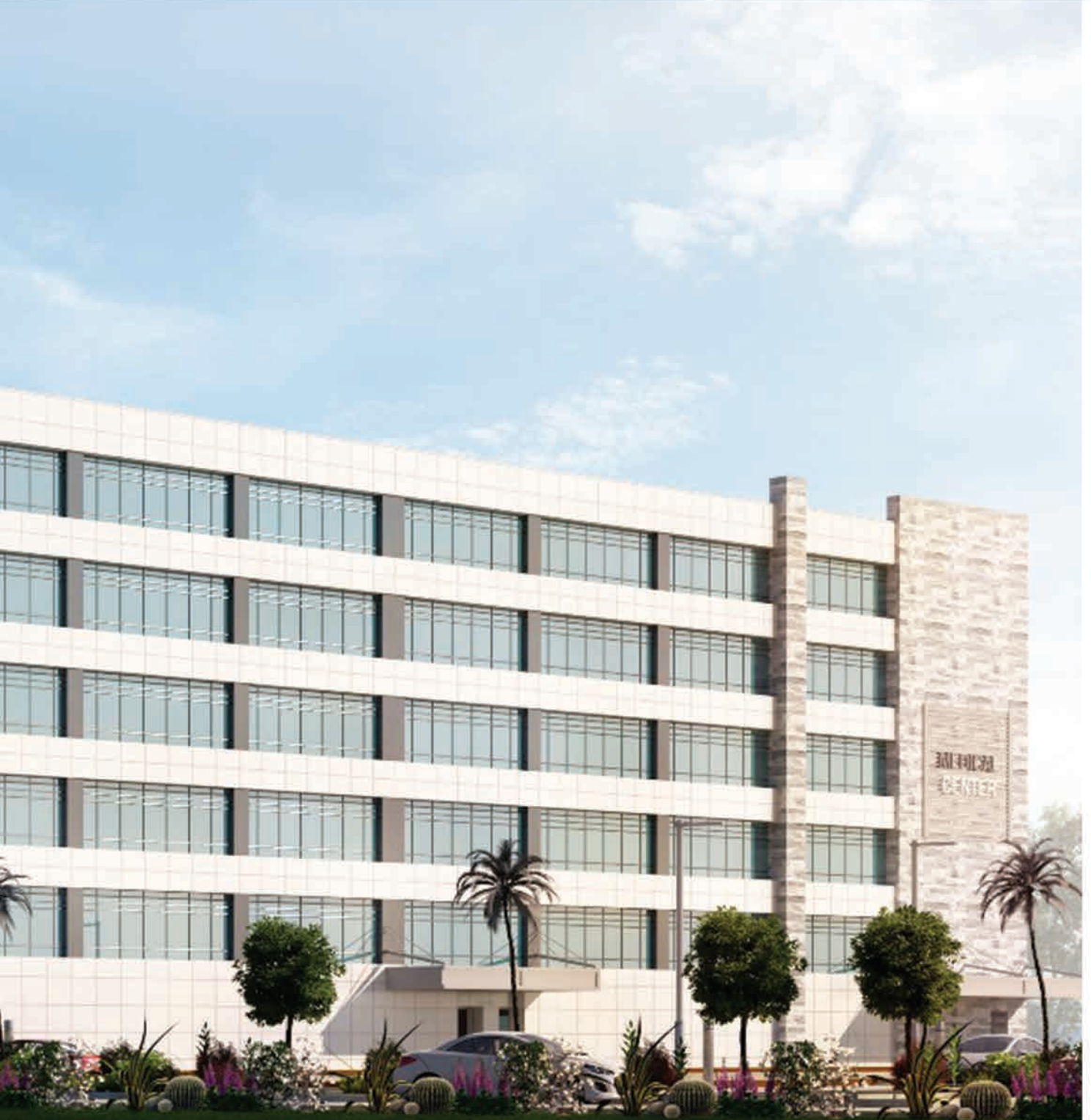
صورة خارجية للمبنى
